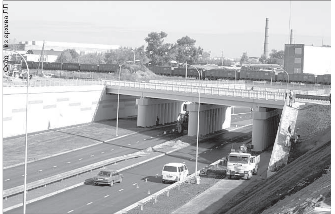
Путепровод, соединивший Форштадт, Новое Строение и «Химию», был открыт 6 лет назад.
