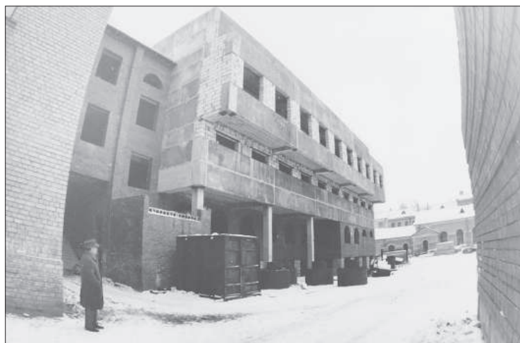
Строительство новой пристройки в 90-х годах.
