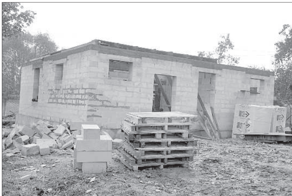
Несмотря на дождь, работы над строительством здания не останавливаются.
