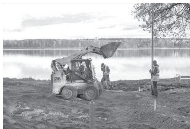
Променады в этом году достроен не будет.
