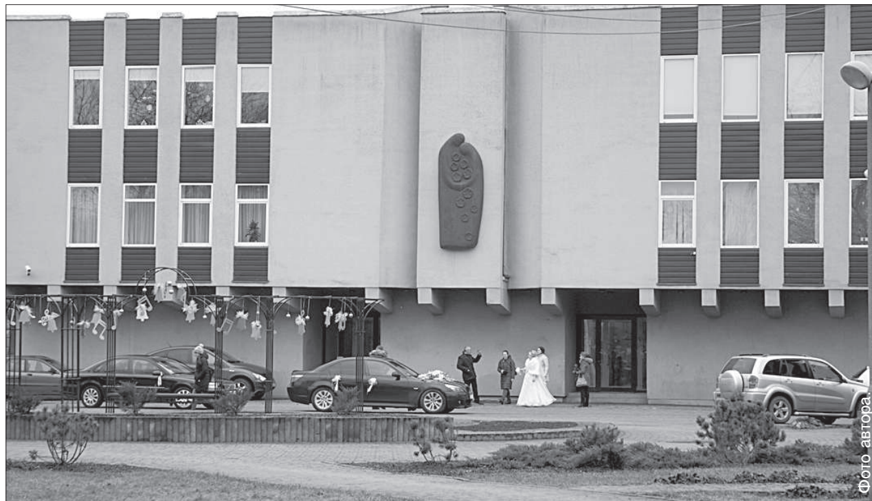
Здание загса построено 36 лет назад.
