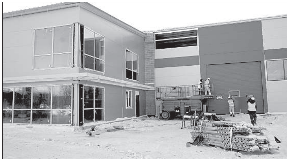
Внешние работы в промышленном парке уже подходят к концу.
