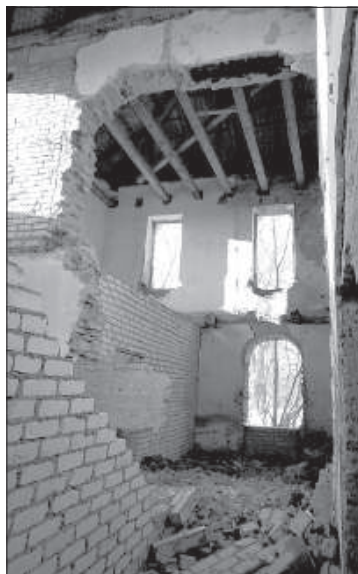
Внутри здания лабиринт из старых стен и кирпичных перегородок.
