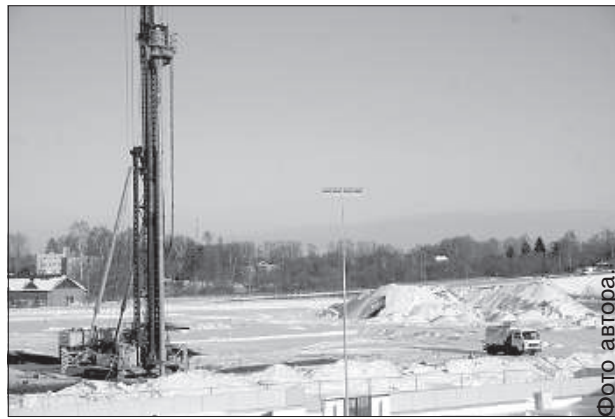
Рядом с уже построенными объектами происходит установка свай для арены.
