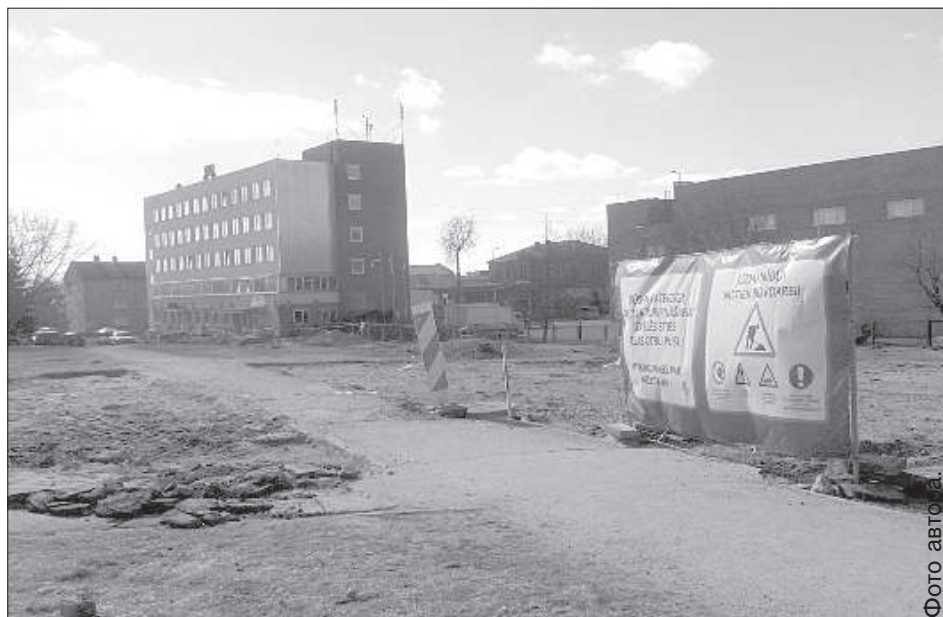
Пятиэтажное здание по адресу Муйтас, 3е полностью занято коммерсантами. Для некоторых из них строительство путепровода — головная боль.
