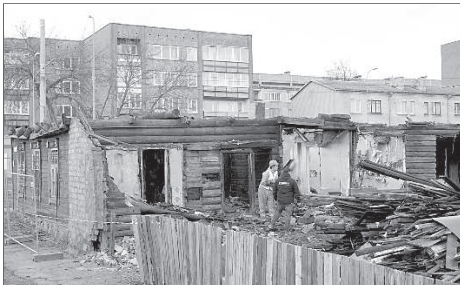
Демонтаж здания идет полным ходом.
