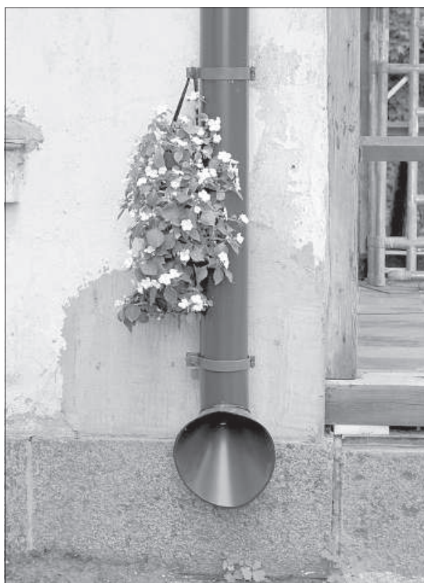
Новые сточные трубы сделаны по образцу старых.
