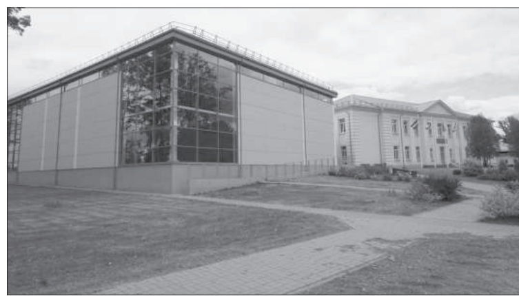
Большой спортзал (спереди) и основное здание школы.
