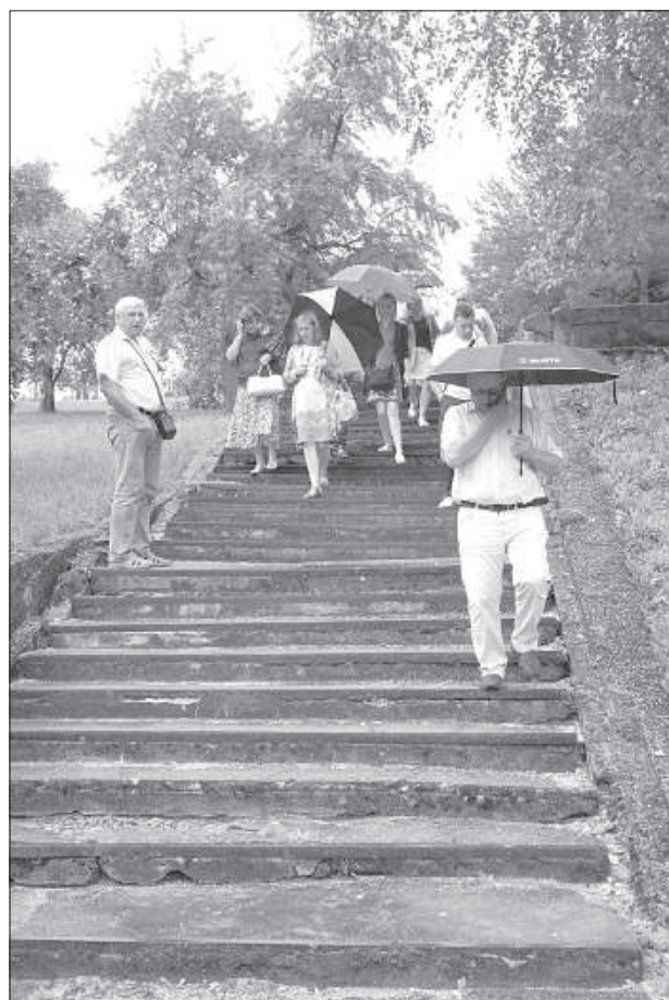
Старая бетонная лестница – самое опасное место.
