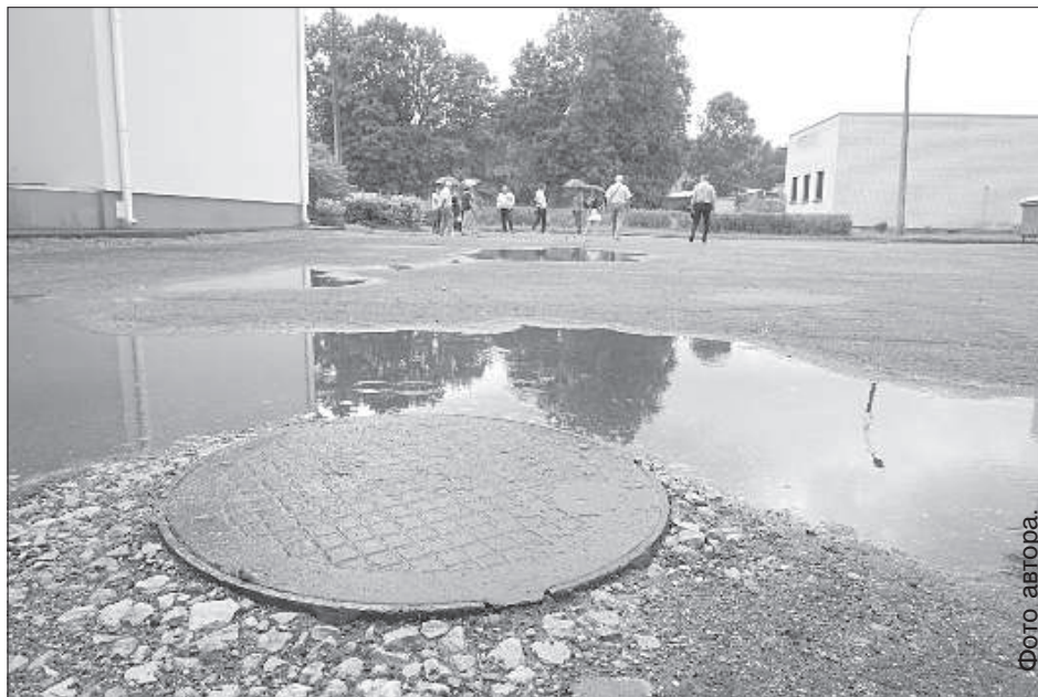
Вода у школы застаивается и течет к фундаменту.
