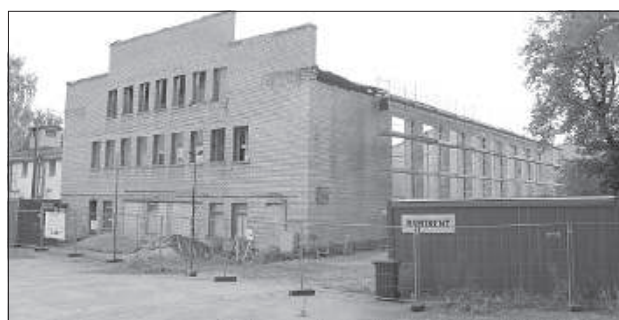
Демонтаж спортзала закончен, но активной стройки не наблюдается.
