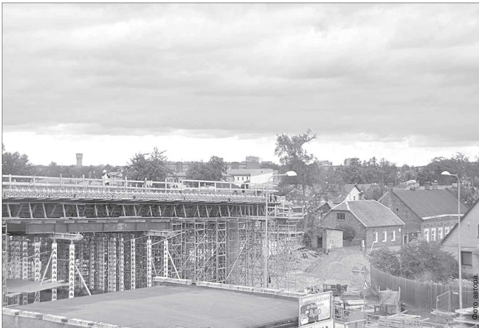
Путепровод строится на высоте трехэтажного дома и располагается вблизи сектора частных домов.
