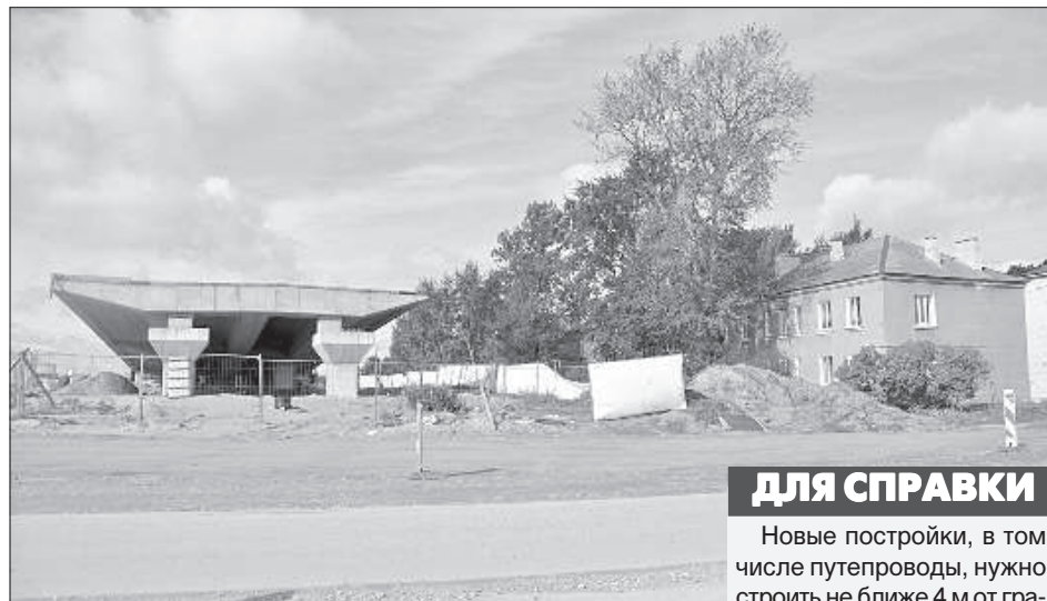
Путепровод строится всего в нескольких метрах от многоквартирных домов.
