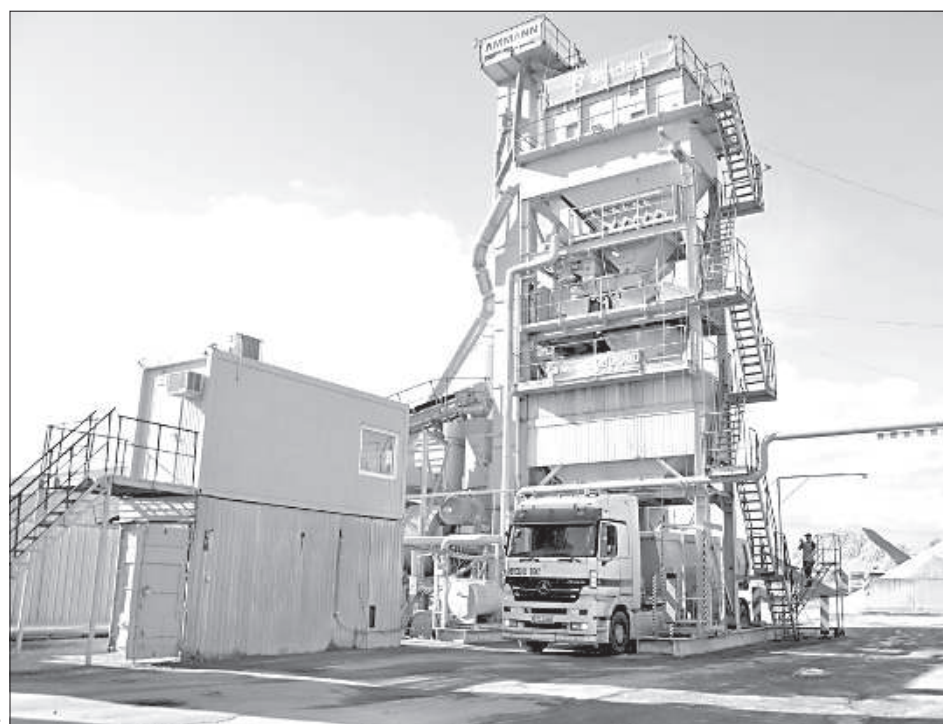
Даугавпилсский асфальтобетонный завод начинает работу в 5:45 утра.
