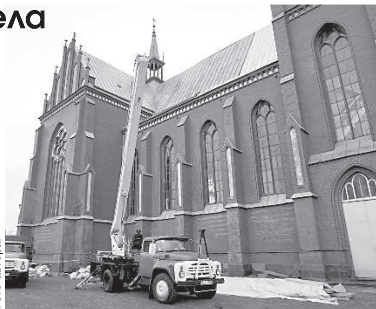
Строители должны завершить замену кровли к середине декабря.
