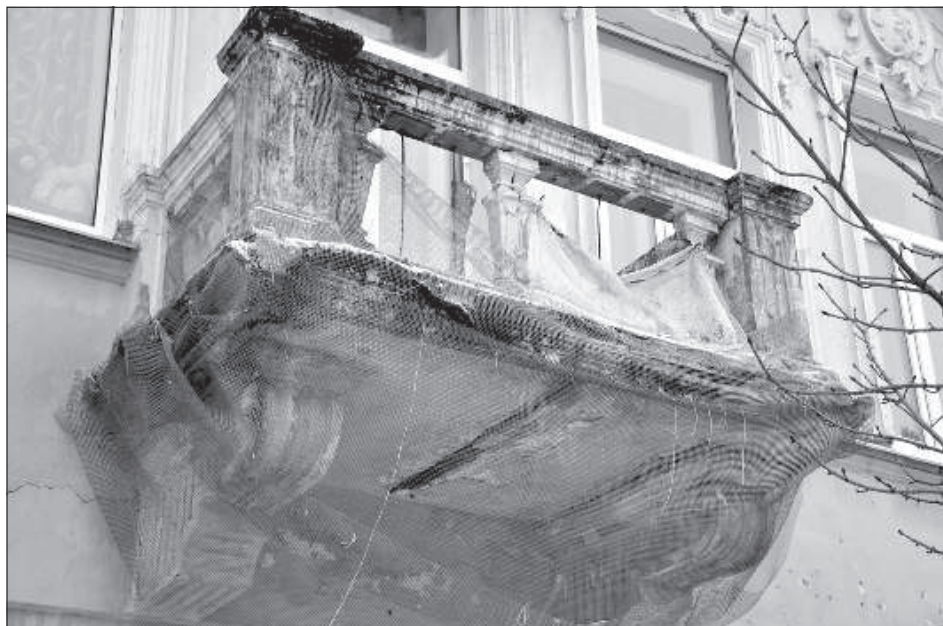
Кратковременное решение, чтобы обваливающийся балкон не упал на прохожих.
