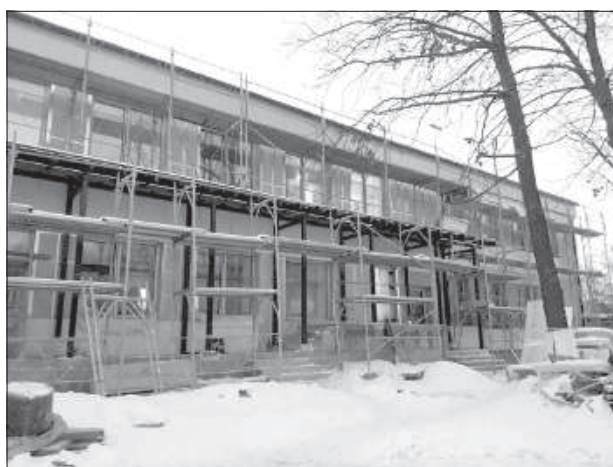
2-й корпус сада еще в лесах.
