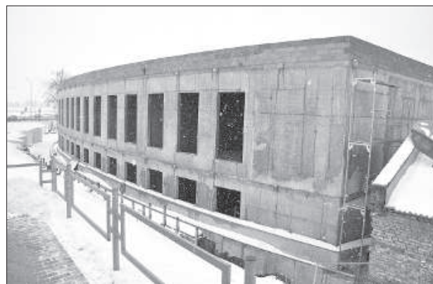
Строительство нового корпуса школы «Saules skola».
