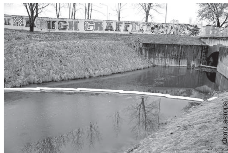
На реке Шунце установлены абсорбирующие боны.
