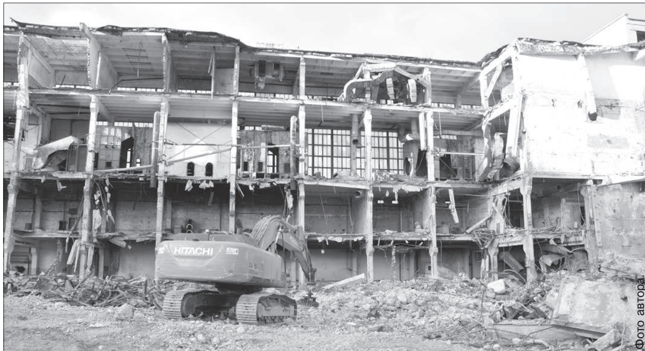
Сносятся не пригодные для производства здания.
