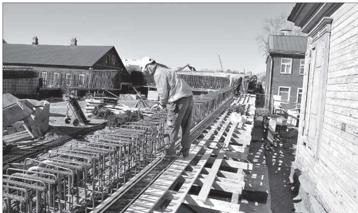
Близость домов затрудняет работу строителей.
