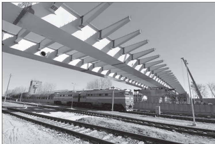
В дальнейшем не нужно будет стоять на железнодорожном переезде.
