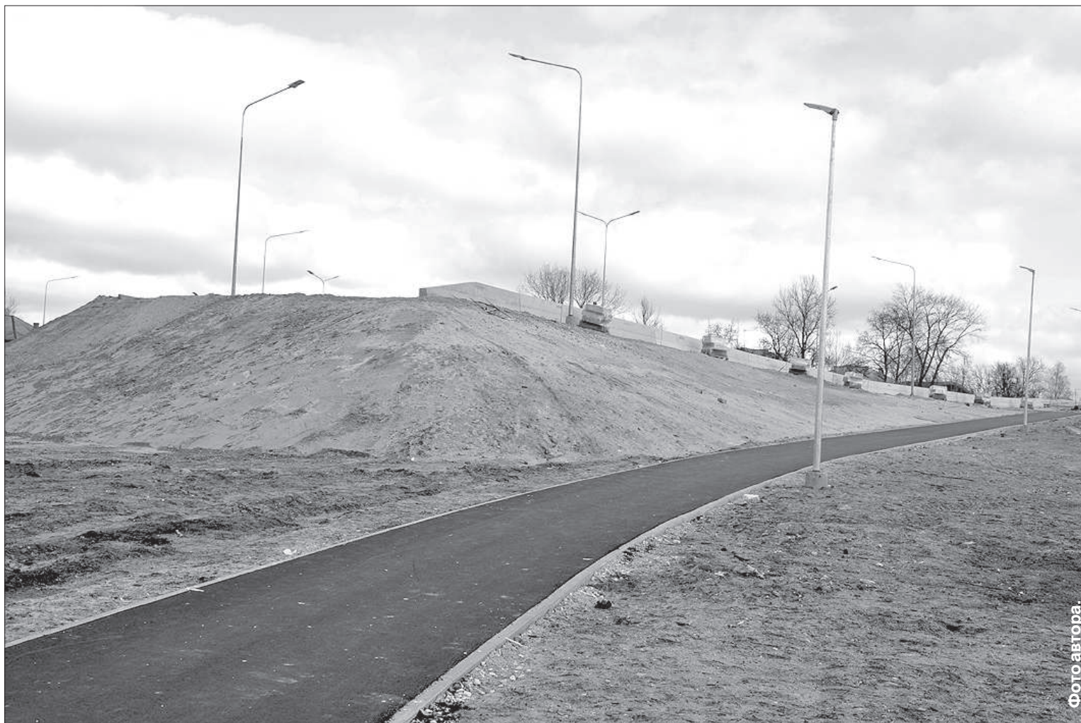
Недостроенное ответвление моста, которое должно вести к центру города.
