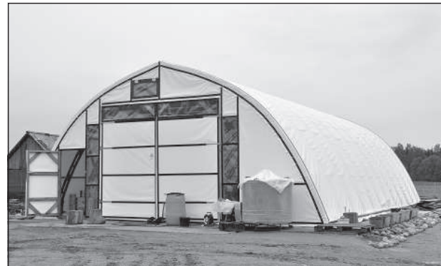
Строится новая ферма.
