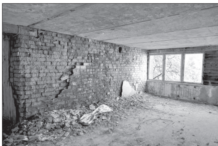
Под влиянием влажности стена из силикатного кирпича начала разрушаться.
