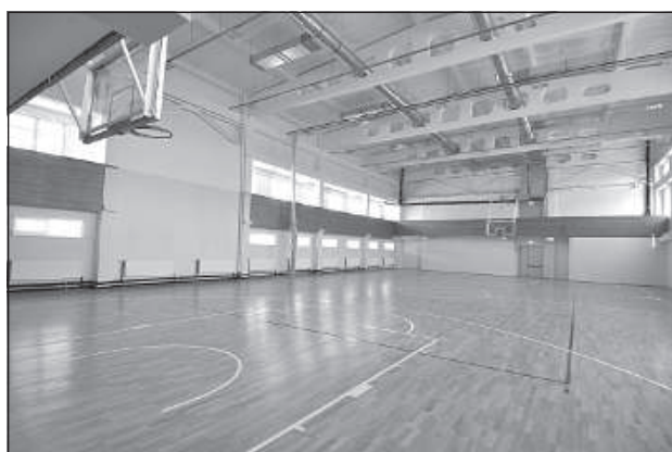
Восстановленный спортивный зал с укрепленными несущими конструкциями.
