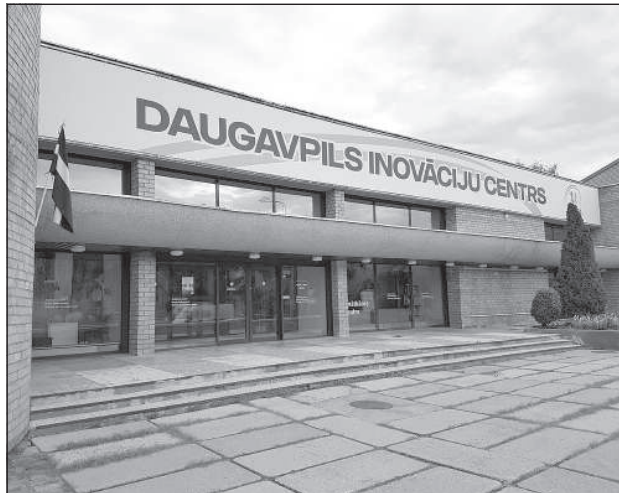
Здесь будет находиться Даугавпилсский центр инноваций.
