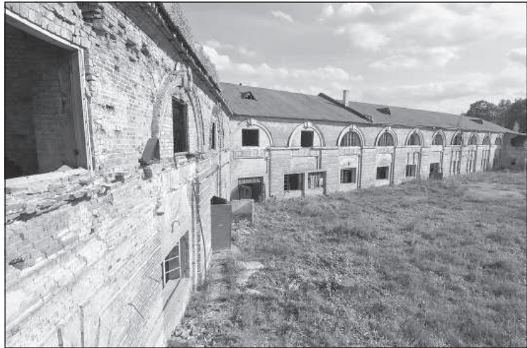
Вид через окно на внутренний двор инженерного арсенала.
