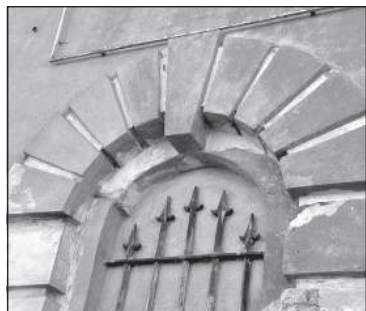
Старинные оконные проемы.
