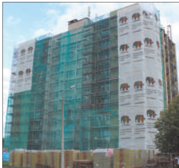
Общежитие на ул. Спорта, 6 ремонтируется.
