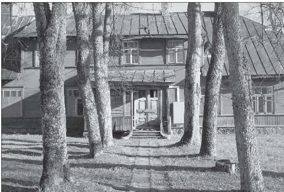
Историческое здание Калупского волостного управления построено в начале 19-го века, входит в число охраняемых объектов культурного наследия Даугавпилсского края.
