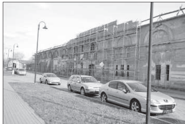
Фасад здания восстанавливается.
