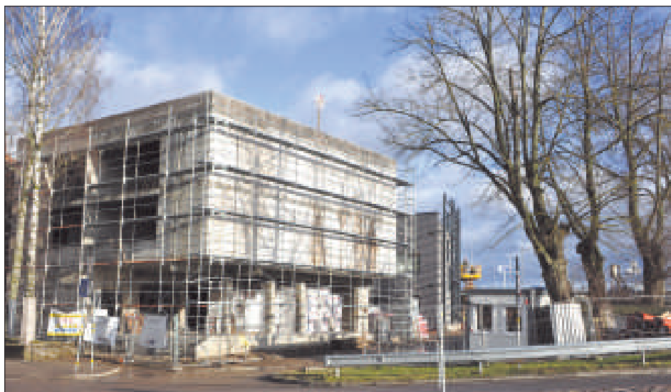
Ведутся работы по установке декоративного фасада.
