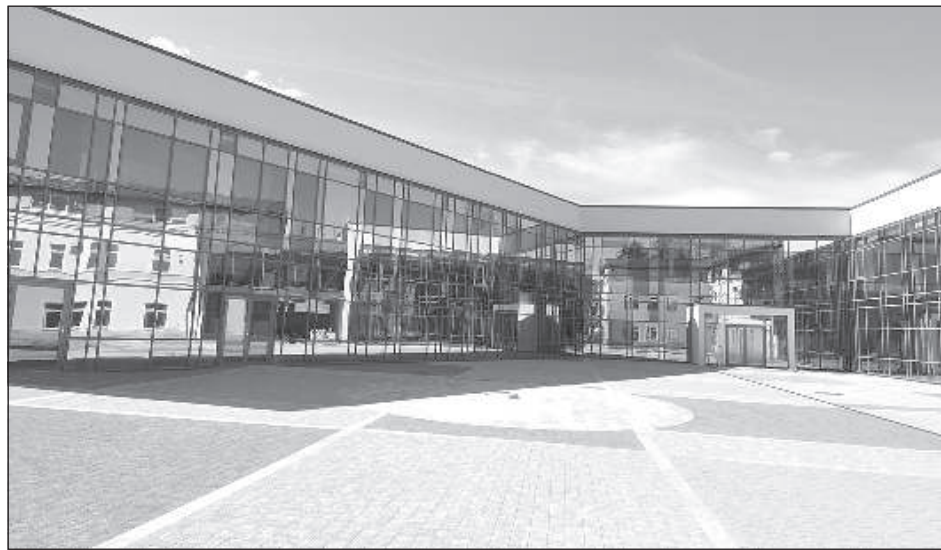
Строительство нового корпуса школы «Saules skola» почти завершено.
