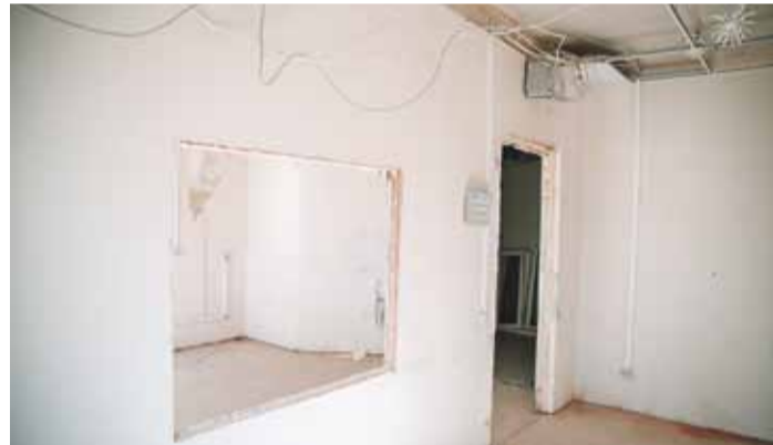
Saulkrastu slimnīcas dienas stacionārs remontdarbu laikā. Foto: Pēteris Gertners
