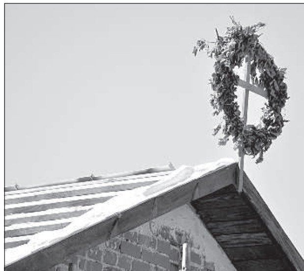
Инженерный арсенал обрел новую крышу.
