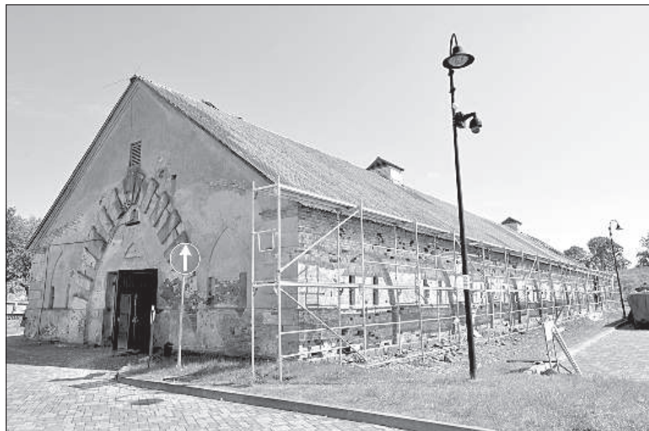
Строительные работы на Пороховом складе идут полным ходом.
