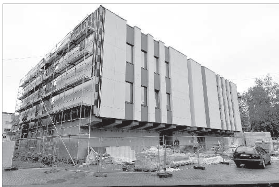
Здание даугавпилсского загса обретает новый облик.
