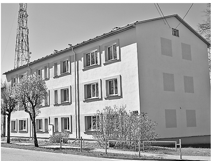
Viens no renovēto namu ieguvumiem – kvalitatīva dzīves telpa un sakārtota vide. Attēlā: daudzdzīvokļu dzīvojamā ēka Liepu ielā 24 mājas iemītniekus un garāmgājējus priecē ar pievilcīgu fasādi.
