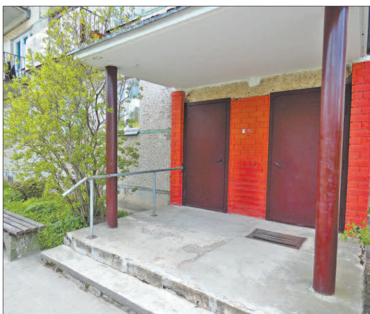
Uzstādītas margas Daugavpils ielā 74
