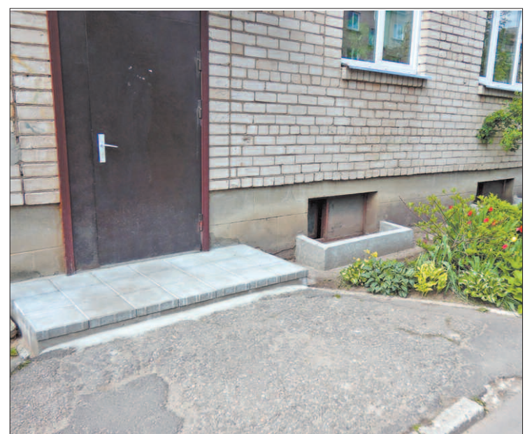
N. Rancāna ielā 2 veikts lieveņu remonts
