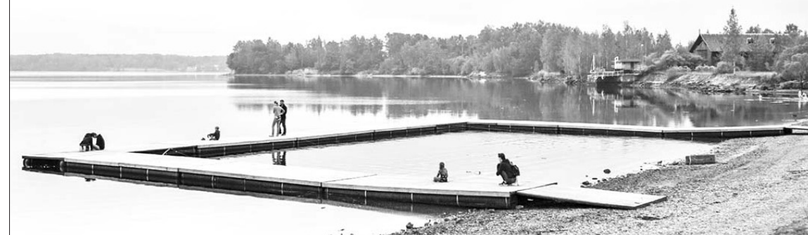
DAUGAVĀ PIE PILSĒTAS KULTŪRAS NAMA novietoti pontoni ērtāki piekļuvei ūdenim.
