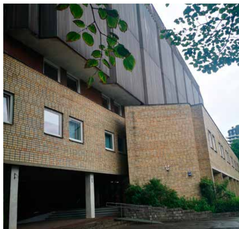
LNA Latvijas Valsts archīva ēka. Joprojām aicinām sūtīt trimdas dokumentus. Personu fondu un ārvalstu dokumentu nodaļa, Latvijas Valsts archīvs, Bezdelīgu iela 1a, Rīga, Latvija LV-1048
