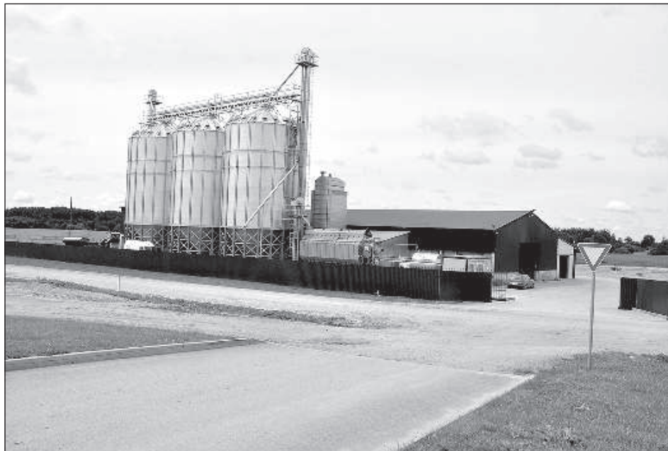
Дорога нуждается в твердом покрытии.
