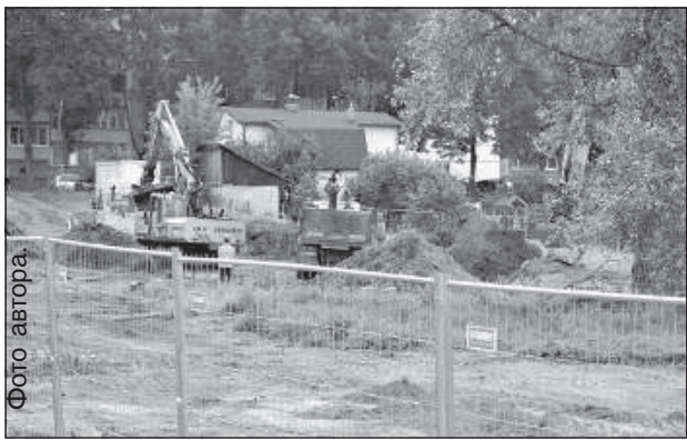
Создается строительная площадка.
