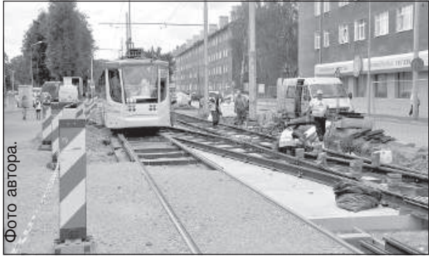
Трамвай на обновленном участке рельсового пути.
