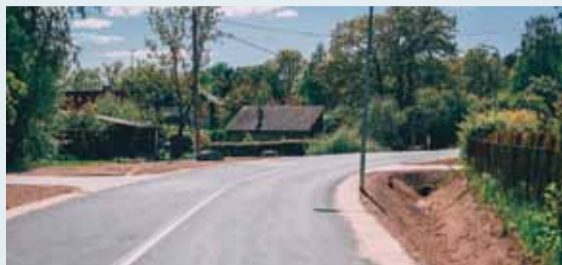
Pabeigta Upes ielas pārbūve
