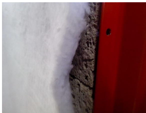
3.32. att. Plātnes prototipa materiāls tiek iestrādāts ārējā izolācijas slānī.
