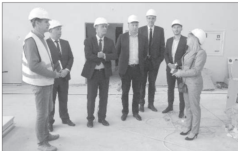
Руководство ЛБС знакомится с ремонтными работами в спорткомплексе ДК.
