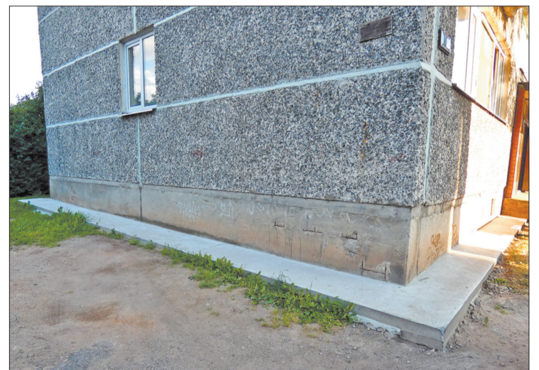
Jelgavas ielā 2 veikts pamatu apmaļu remonts
