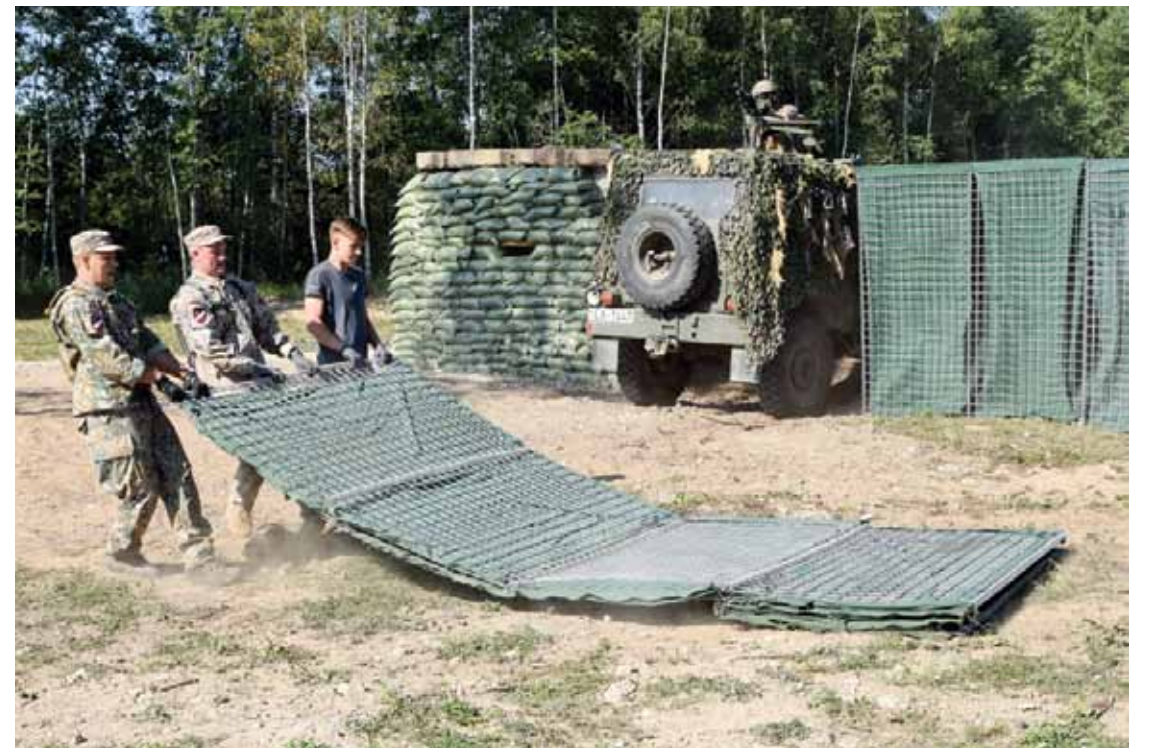
Zemessardzes 2. Vidzemes brigādes 54. inženiertehniskā bataljona kaprālis Oskars Čodors uzskata: ir tādas jomas, kurās vēl jāaug. Kā piemērs tiek minēta vajadzība iegādāties bastionus – ar tiem ātrāk un efektīvāk var aizsargāt gan dzīvo spēku, gan tehniku.
