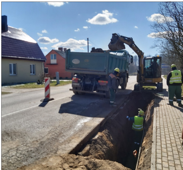
Jauna kanalizācijas vada izbūve Zingberga ielā
