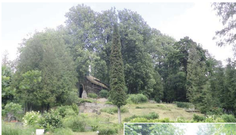
Kempju kapsētas kapličas jumta remonta 07.07.2020. Foto Rasma Vanaga.
