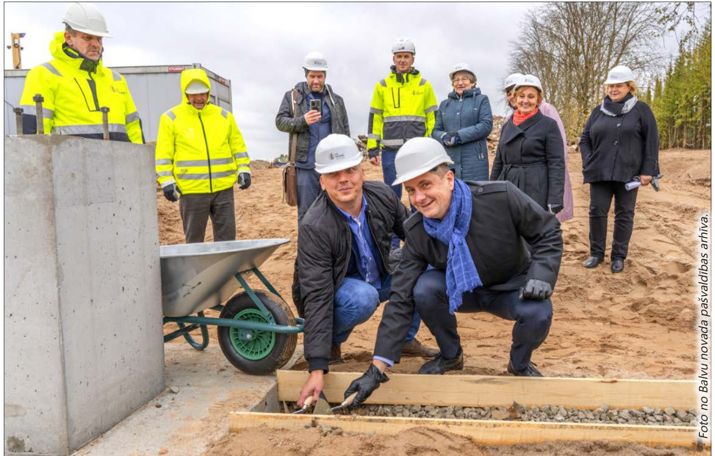
SIA "LVS Building" valdes loceklis Normunds Lācis un Balvu novada pašvaldības domes priekšsēdētājs Aigars Pušpurs ierok kapsulu vienā no industriālās ēkas pamatiem.
