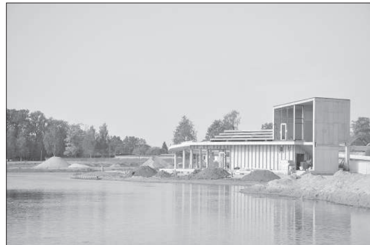
На берегу озера Ковшу строится ресторан.
