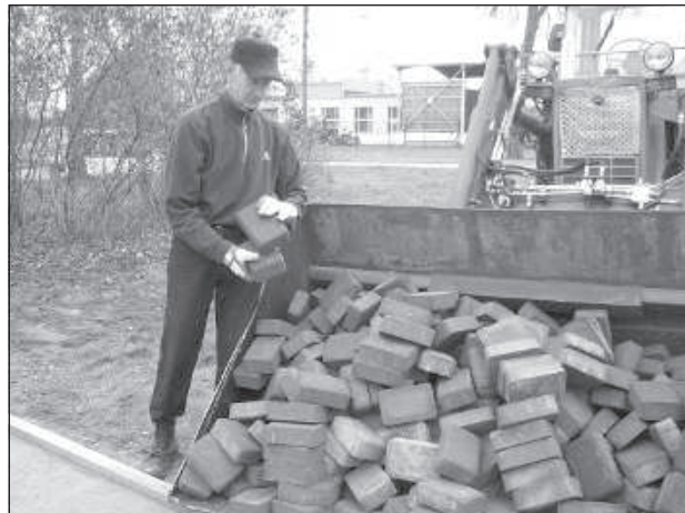
Идут работы по укладке плитки.
